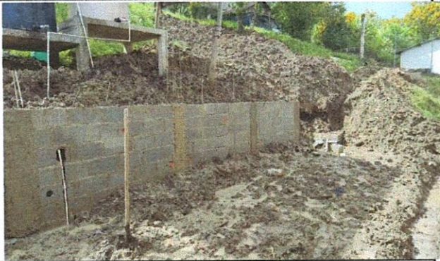
Foto 1: MEJORAMIENTO DE CORRIENTE DE AGUA PLUVIAL
