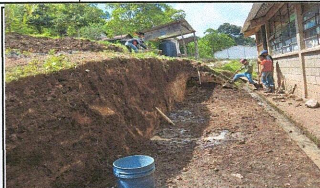
Foto 2: ÁREA PARA MEJORAMIENTO DE CUNETAS CON FECHA 10 DE NOVIEMBRE
