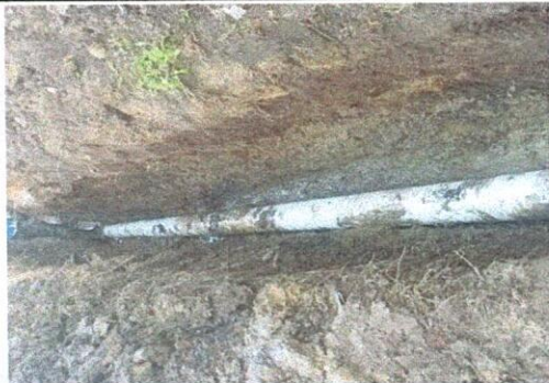
Foto 3: COLOCACIÓN DE TUBOS DE 6" PARA CORRIENTE DE AGUA PLUVIAL
