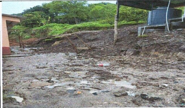
Foto 2: AREA MEJORAMIENTO PISO Y LOSA
