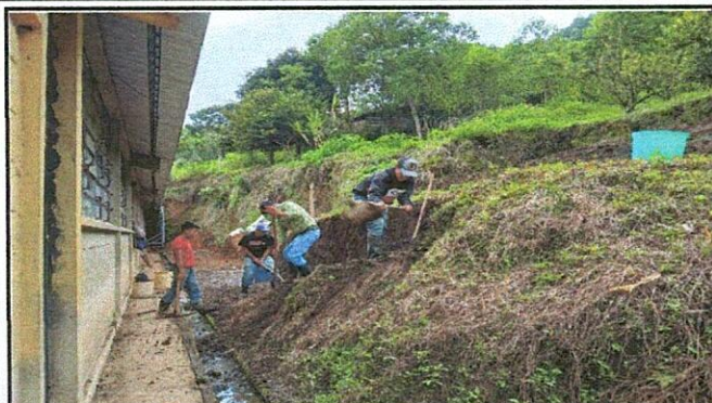
Foto 1: ÁREA PARA MEJORAMIENTO DE CUNETAS CON FECHA 5 DE NOVIEMBRE
