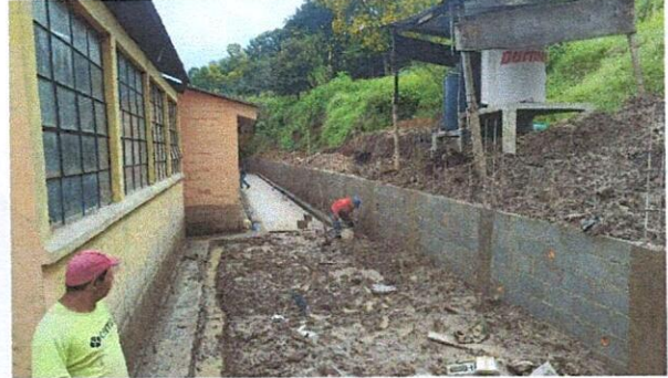
Foto 2: MEJORAMIENTO DE TUBERIA DE CORRIENTE DE AGUA PLUVIAL
