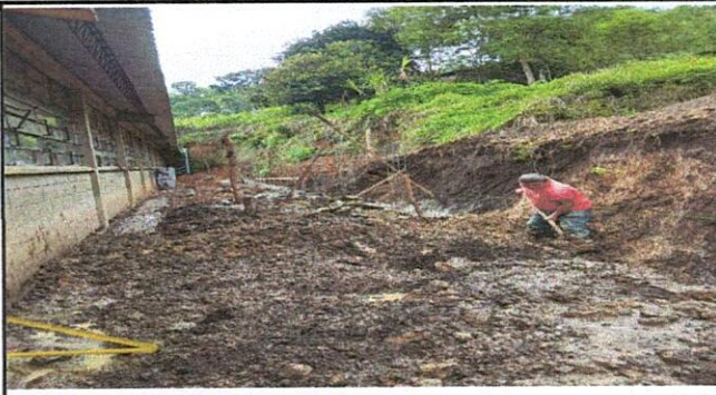
Foto 4: LIMPIEZA DE AREA DERRUMABADA
