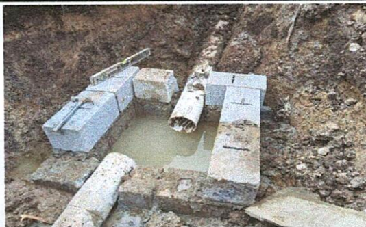
Foto 5: COLOCACIÓN DE TUBO DE PVC 6" PARA CAJA DE CAPTACIÓN DE AGUA PLUVIAL
