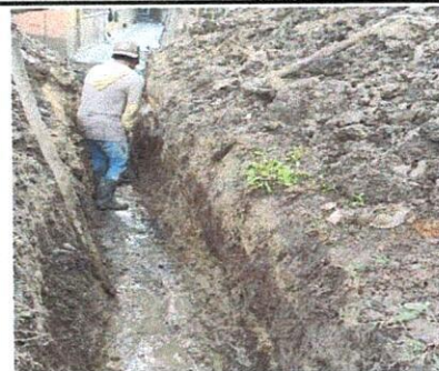
Foto 6: EXCAVACIÓN PARA COLOCACIÓN DE TUBO PVC 6" PARA CORRIENTE DE AGUA PLUVIAL
