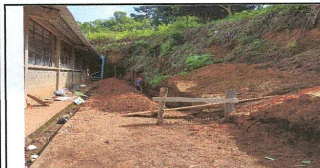
Foto 3: ÁREA PARA MEJORAMIENTO DE MURO DE CONTENCIÓN CON DRENAJE FRANCES
