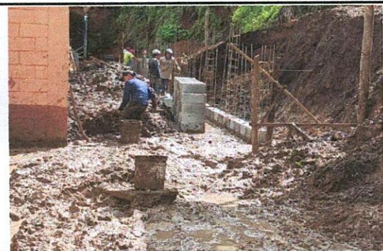
Foto 3: LIMPIEZA DE AREA PARA PISO Y LOSA
