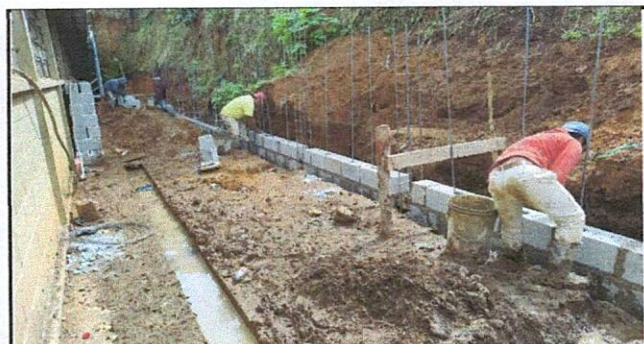
Foto 4: CONTINUACIÓN DE COLOCACIÓN DE FILAS DE BLOCK, DE MURO DE CONTENCIÓN CON DRENAJE FRANCES
