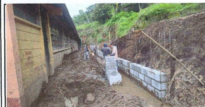
Foto 5: ÁREA PARA MEJORAMIENTO DE MURO DE CONTENCIÓN CON DRENAJE FRANCES
