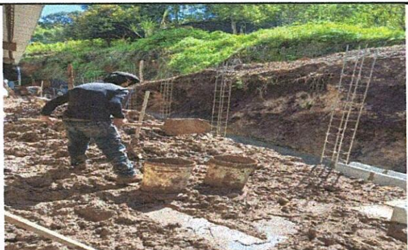
Foto 1: LIMPIEZA DE AREA PARA PISO Y LOSA
