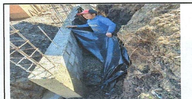
Foto 6: ÁREA PARA MEJORAMIENTO DE MURO DE CONTENCIÓN CON DRENAJE FRANCES
