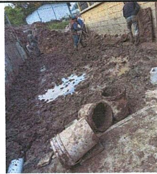
Foto 4: EXCAVACIÓN PARA COLOCACIÓN DE TUBO PVC 6"
