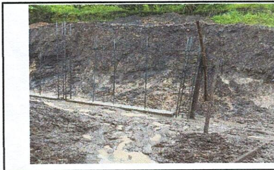
Foto 6: LIMPIEZA DE AREA DERRUMBADA
